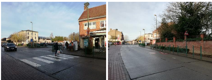
Photo 74 & 75 : passages pour piétons rue du Berceau (Marbais)
