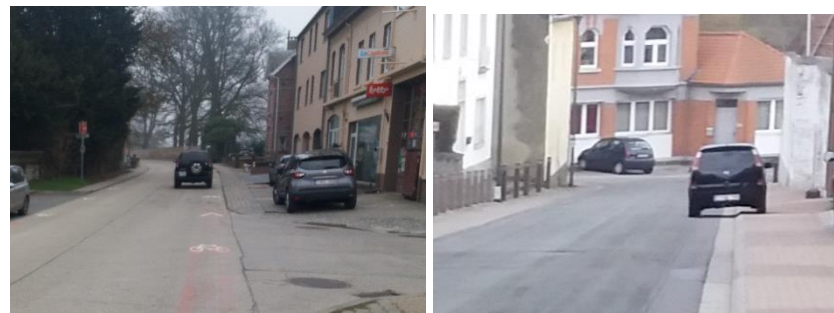
Photos 15 & 16 : rue de Priesmont (Marbais) & rue E. Deltenre (SDA)
