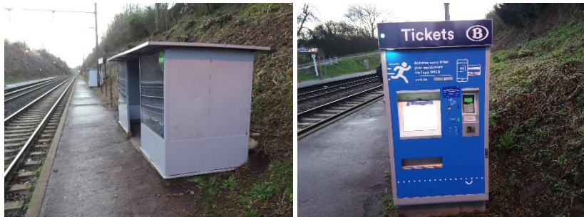
Photos 47 & 48 : Abri et distributeur au PANG de Villers-la-Ville
