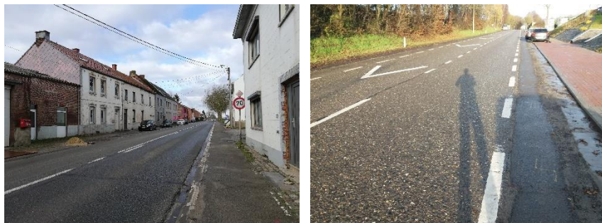
Photos 28 & 29 : N93 à hauteur de Marbais (g.) et N275 au nord de l'agglomération de Marbais (dr.)
