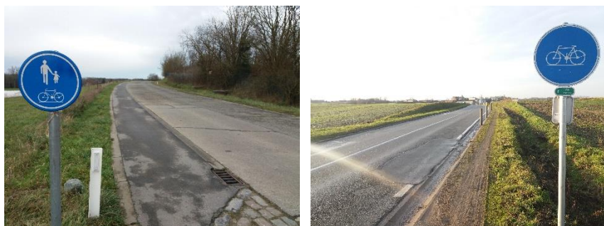
Photos 32 & 33 : piste cyclopiétonne (D10) bidirectionnelle sur la rue de Gentissart entre Tilly et Mellery, et piste cyclable unidirectionnelle (D7) sur la rue de Chassart vers Wagnelée
