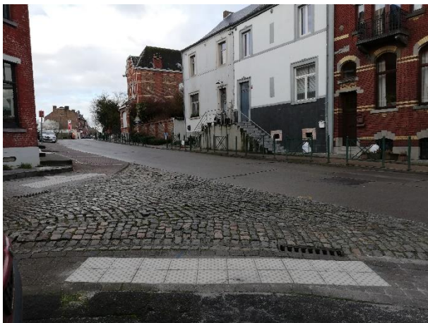
Photo 26 : Place F. Laghain (Marbais)
